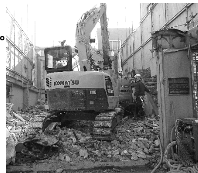
解体工事には必須の資格です
